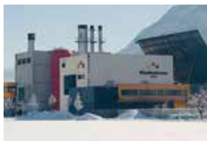
Heizwerk der Stadtwärme Lienz
